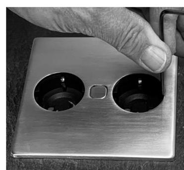
Über die Schrauben (Innensechskant) die Flügel an der
